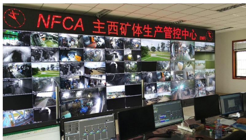
圖 1 主、西礦體生產調度指揮中心
